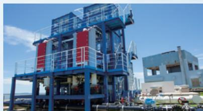
太陽で温められた海面の表層水と深海の冷たい深層水の温度差で発電する「海洋温度差発電」の、世界唯一の実用実証設備が稼働しています。将来、島の電力を100%再生可能エネルギーで自給することを目指しています。
